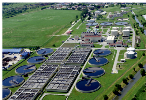
Станция очистки сточных вод Краков-Плашов
